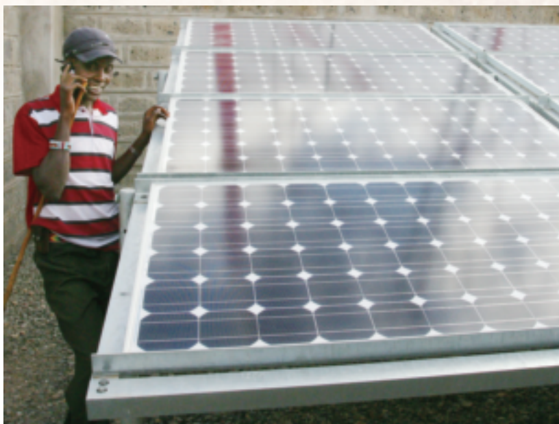
南非經濟發展長期受缺電之苦，傳統燃煤發電不足，採行分區限電卻帶動電價高漲，南非政府目前全力投入太陽能發電建設。
