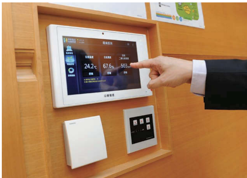
智慧家庭的中控平台，使用者可透過面板來控制管理室內環境的溫度。
