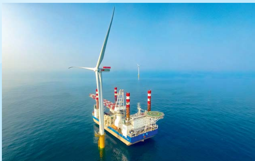
上緯新能源的離岸風電機，今年4月於苗栗外海正式運作，這是第一座由台灣開發商建造並正式商轉的離岸風力發電機組，對台灣能源產業別具劃時代意義。
