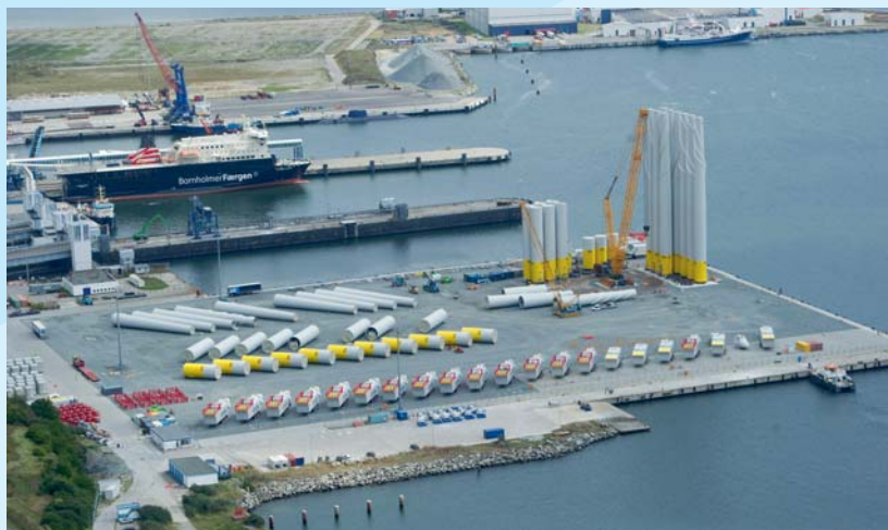
用以裝卸、製造、組裝與儲存風電設備的重裝碼頭，是發展離岸風電不可缺少的基礎建設。
